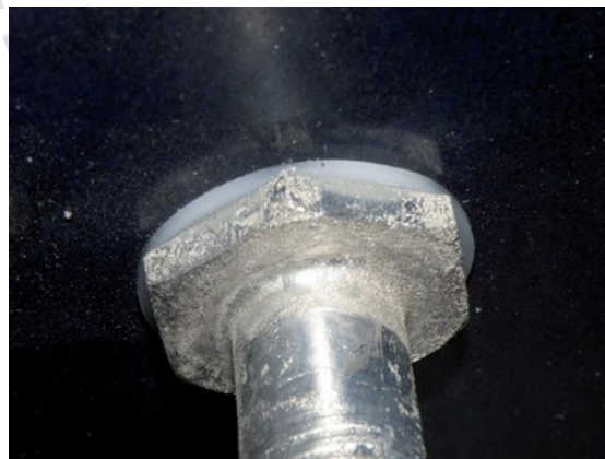
Hőcserélő szigetelt elválasztásáról a „Tartályok” karimájától
