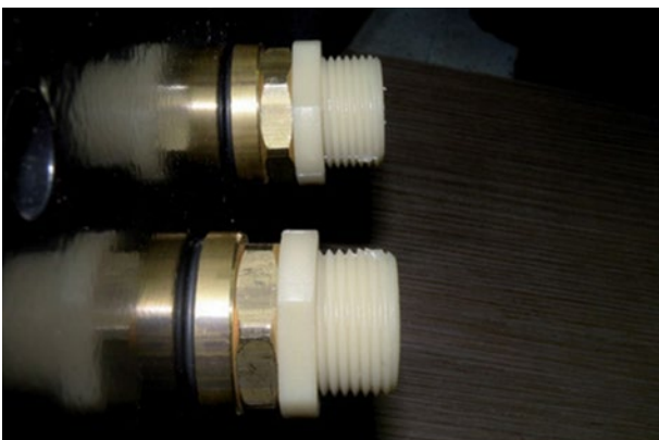
A réz hőcsereélő szigetelt elválasztása az előremenő és visszatérő csövektől
