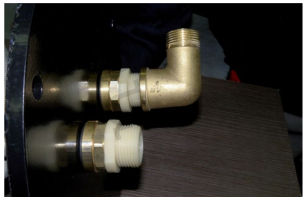
A réz hőcsereélő szigetelt elválasztása az előremenő és visszatérő csövektől
