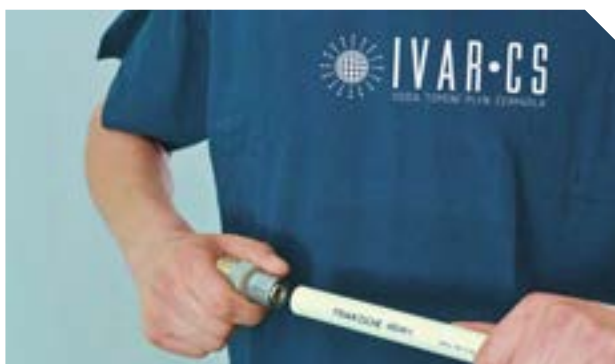
IVAR.PRESS idom illesztése a sorjáltlanított és kalibrált csőre.
