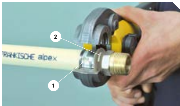
Az IVAR.ALPEX cső és IVAR.PRESS préselős fitting, préselés minőségének vizuális ellenőrzése
